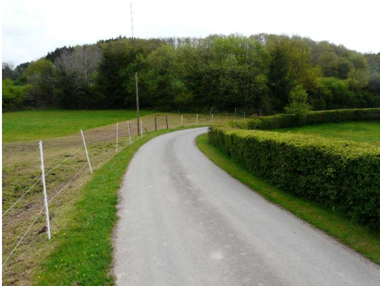
Abb. 30: Asphaltierter Wirtschaftsweg als Zufahrt zur Dornauelsmühle – Mai 2010
