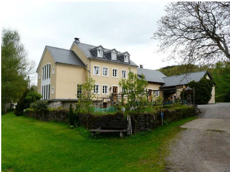
Abb. 28: Dornaueismühle an der Fußgängerbrücke nach Luxemburg – Mai 2010
